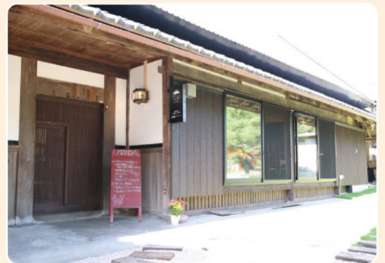
リノベーション古民家のおしゃれな空間
